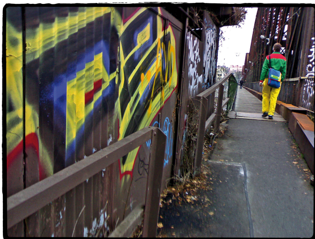
NA ŽELEZNIČNÍM MOSTĚ 2007
